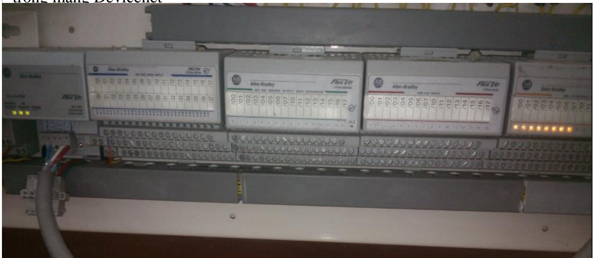
Hình 8: Hoạt động của Slave được điều khiển bởi Master trong qua mạng Devicenet
